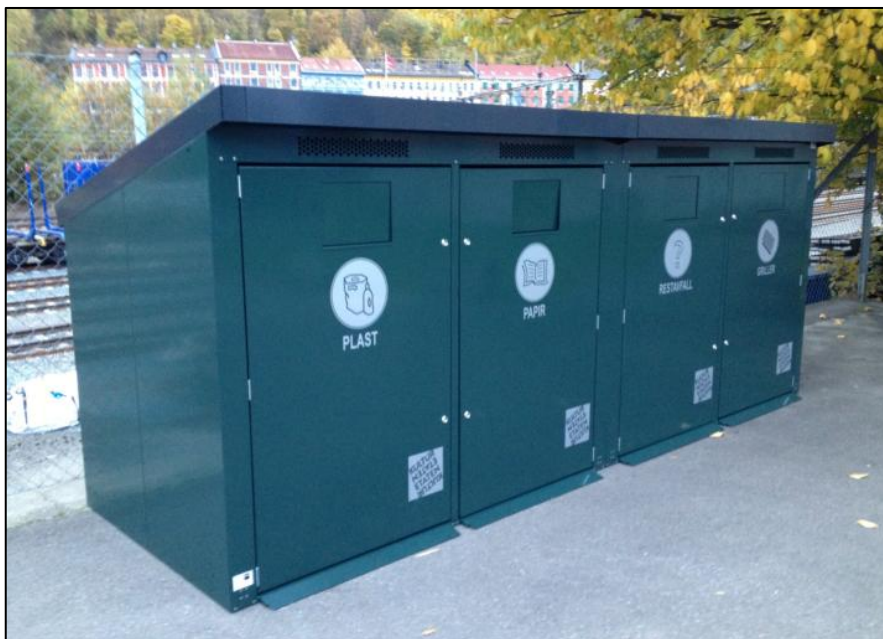
Figur 5-6: Eksempel på brannhemmende beholderskap
