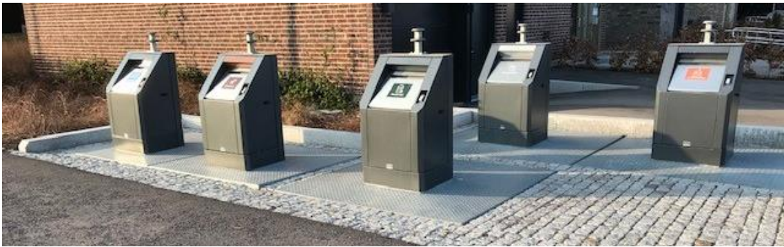
Figur 3-5: Helt nedgravd containerløsning for 5 avfallstyper
