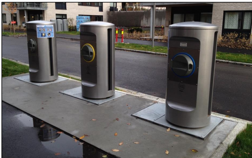
Figur 3-7: Nedkast til stasjonært avfallssug – 3 avfallstyper
