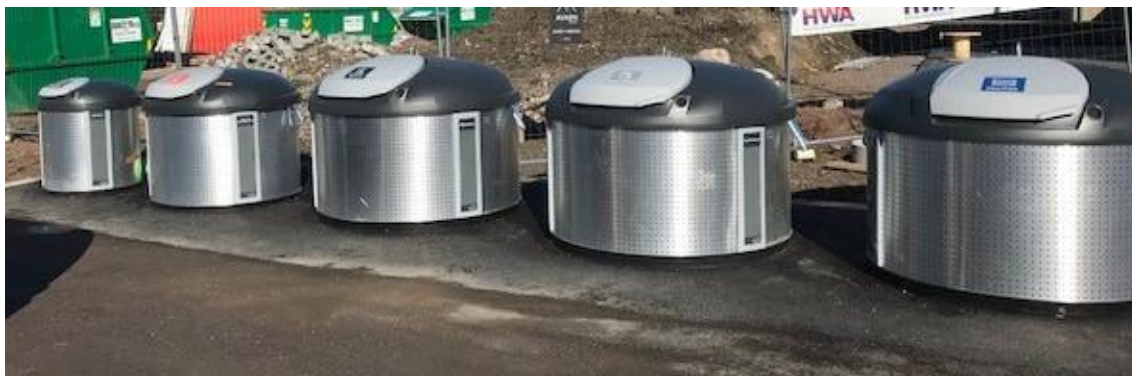
Figur 3-4: Delvis nedgravd containerløsning for 5 avfallstyper
