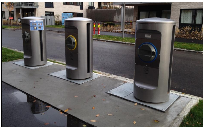
Figur 3-7: Nedkast til stasjonært avfallssug – 3 avfallstyper
