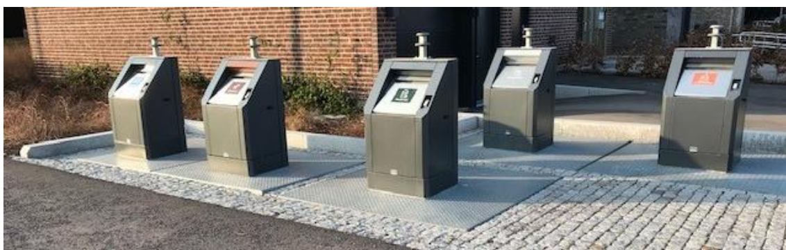
Figur 3-5: Helt nedgravd containerløsning for 5 avfallstyper
