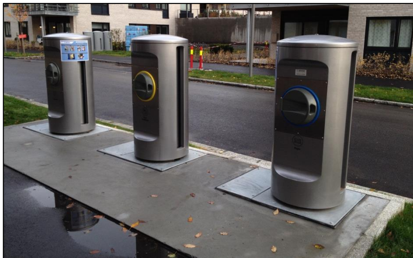
Figur 3-7: Nedkast til stasjonært avfallssug – 3 avfallstyper
